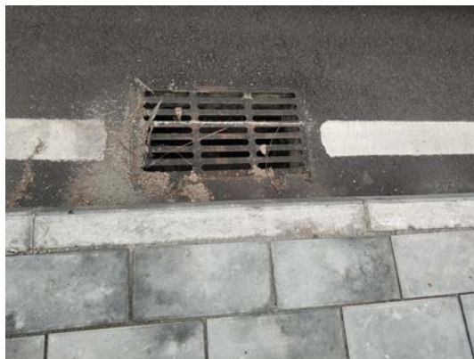
环厂路东段排水口
